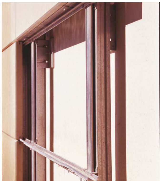
In basso: particolare posa in opera di parete ventilata con rivestimento in Pietra leccese Below: Air chamber cladding laying with Pietra leccese for cladding
